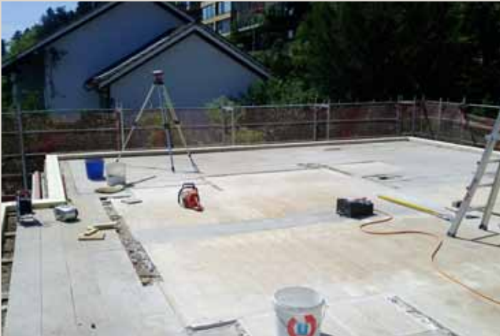
Situation nach der Demontage es alten Dachstockes.
