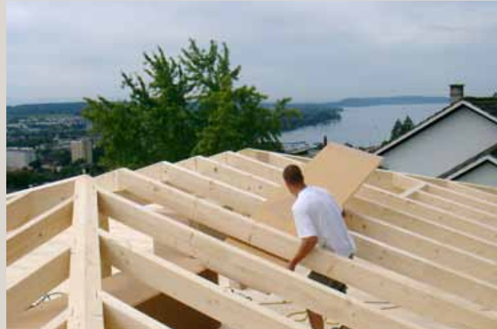
Der neue Dachstock wird montiert.
