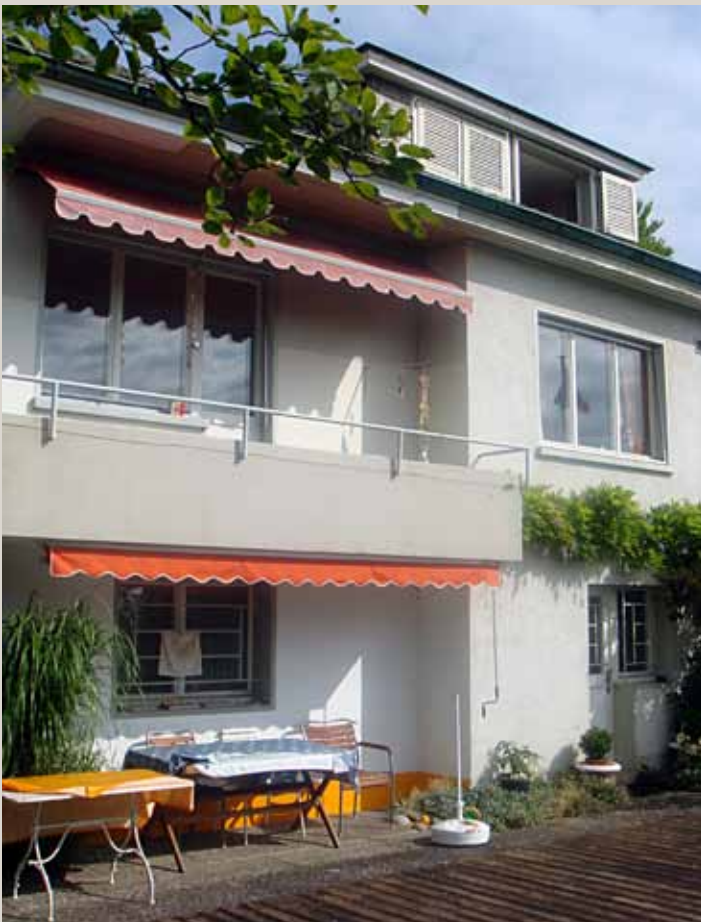
Südansicht des EFH mit dem UG vor der Aufstockung.
