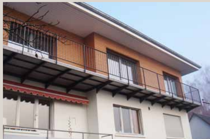
Neue Südansicht nach der erfolgreichen Aufstockung.
