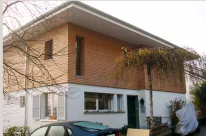
Das Einfamilienhaus nach der Aufstockung – ein modernes Haus mit mehr Platz zum leben.
